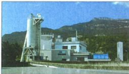
L'impianto di Wet Oxidation di Rovereto (TN)
